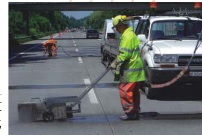
Beim Reinigen der Fugenmulde kommt unser speziell entwickelter Jet-Roboter zum Einsatz. Er ermöglicht das Entfernen alter Fugendichtungsmassen.
