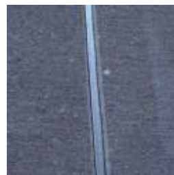
In zwei Arbeitsgängen verfüllte Kontraktionsfuge.
