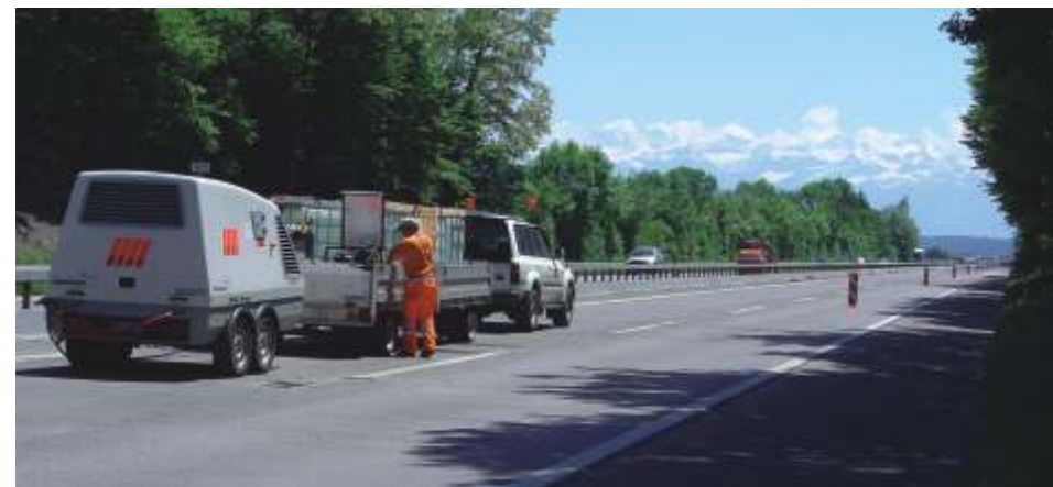
Die Instandsetzung erfolgt kontinuierlich. Wir legen grossen Wert auf eine perfekte Ausführung aller Arbeiten und sorgen jederzeit dafür, dass der Verkehrsfluss möglichst störungsfrei aufrecht erhalten wird.
