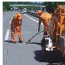
Sorgfältiger Heissverguss mit Pumpkocher und Lanze bei konstanter Temperatur.
