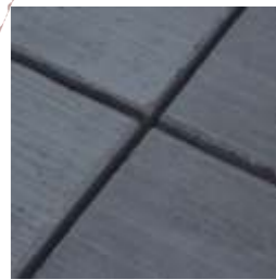
Vorbereitete Kontraktionsfuge bei einer neu erstellten Beton-Verkehrsfläche.
