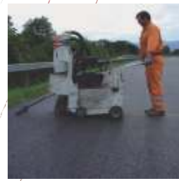
Schneiden der Fugen im Trockenschnittverfahren mit Absaugung.
