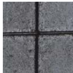
Fertig vorbereitete Kontraktionsfuge bei einer Instandsetzungs-massnahme.
