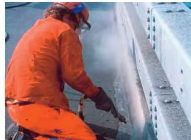
Reinigung der RESA-FLEX Randanschluss-Fuge
